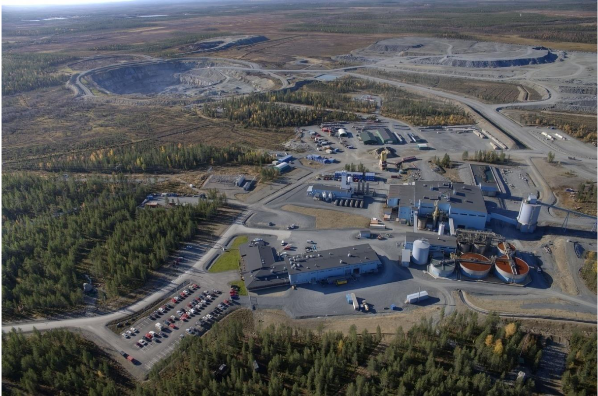
Σχήμα 2.4-1. Πανοραμική άποψη του Μεταλλείου Kittila στη Φινλανδία
